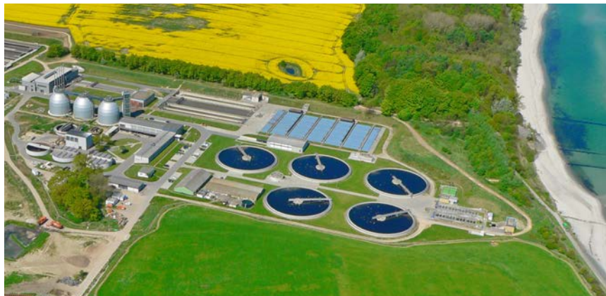
La planta depuradora de Kiel-Bülk: aquí se utilizan bombas multifase EDUR para la flotación.
